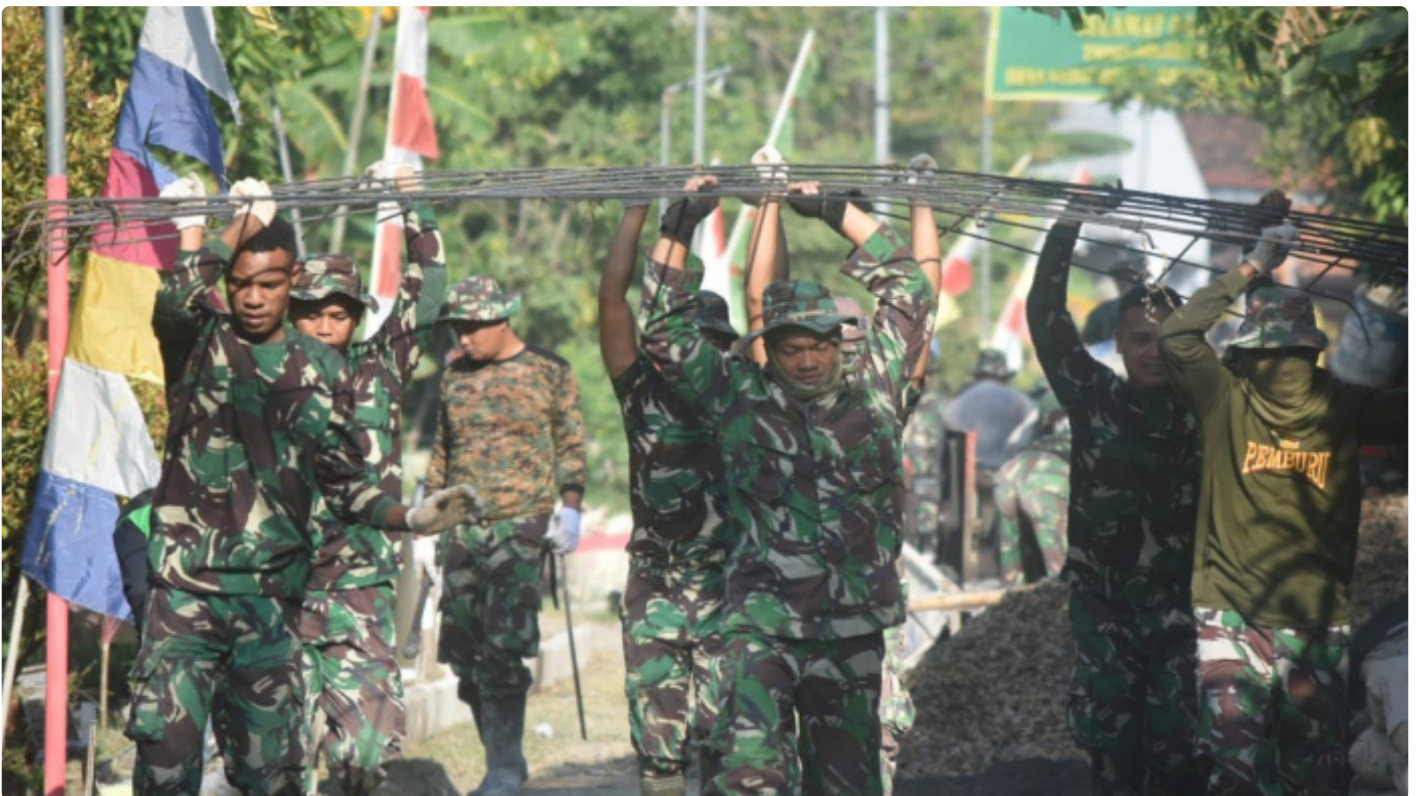
TMMD Reguler ke-114 Kodim 0716/Demak Sasaran Pengecoran Jalan Desa Kebonagung, Demak.
